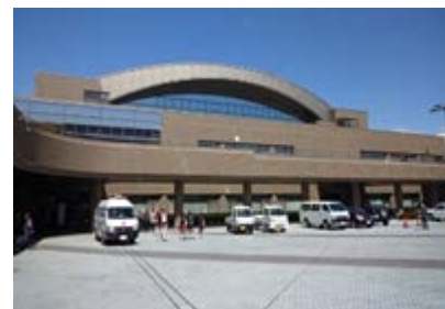
あづま運動公園体育館
